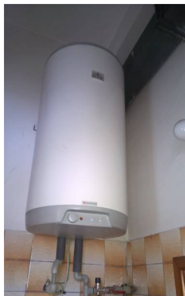
Obrázek 6: Elektrokotel MORA.
