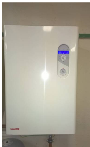
Obrázek 6: Elektrokotel MORA.
